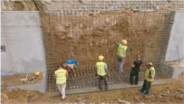
▲ Les murs en béton armé ▲
