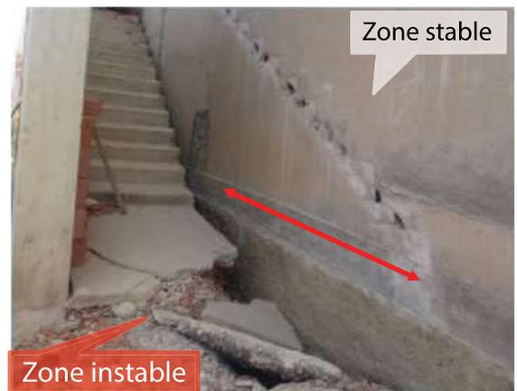
Détachement d'un escalier extérieur situé dans la zone du terrain en mouvement
