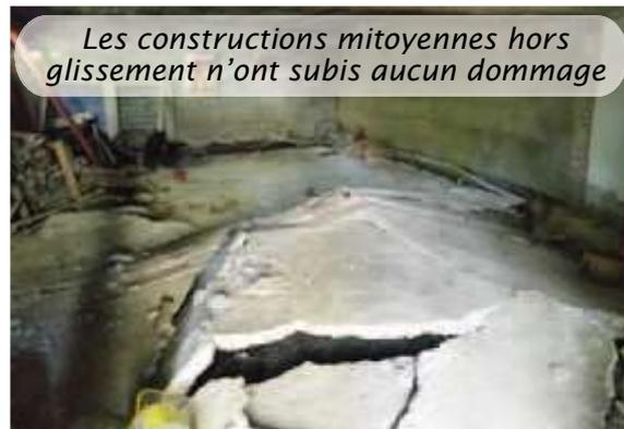
Soulèvement du terrain au niveau d'un entresol d'une bâtisse.
