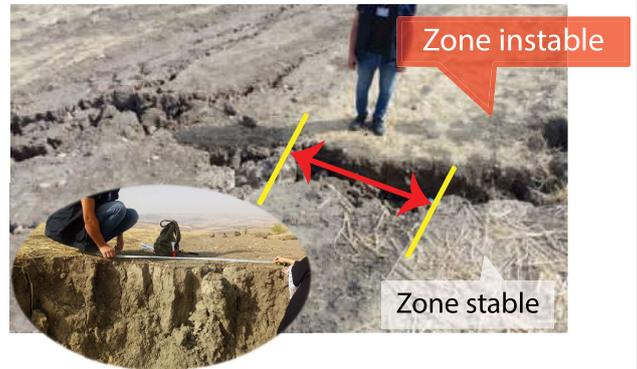
Affaissement d'une piste avec constat d'un décrochement d'environ 1,30m
