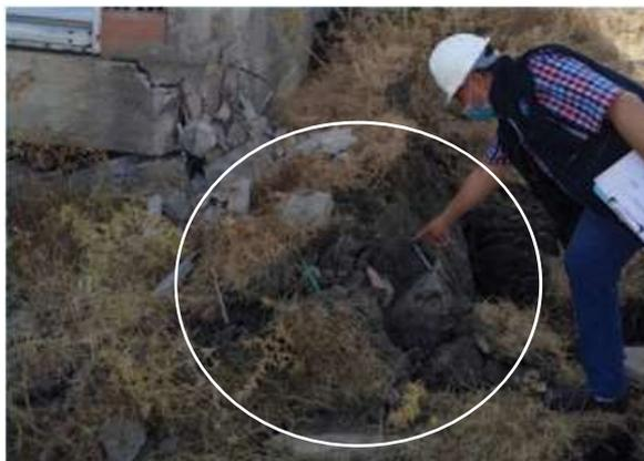
Déplacement global d'une structure avec un «fauchage» d'une semelle de rive
