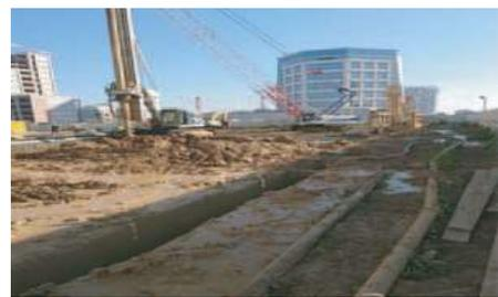
**Etape 2 : Réalisation des panneaux de la paroi et excavation de la fouille**
