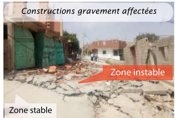
Déformation d'une voie avec dislocation du bitume; délimitant la zone stable de la zone en mouvement
