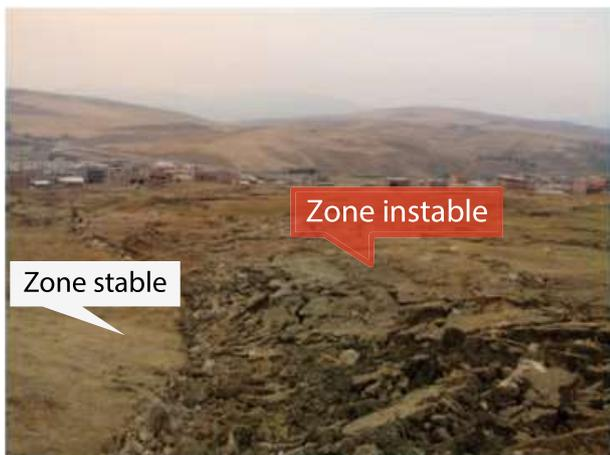
Vue d'ensemble sur la zone Nord Ouest du glissement. La limite du glissement et nettement visible a cet endroit
