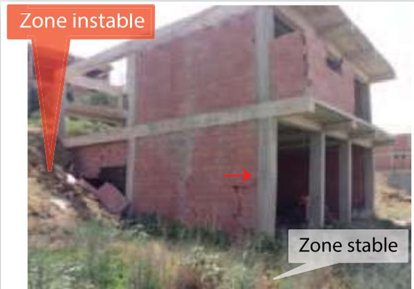
Zone Nord du glissement. Flambement des poteaux du RDC sous l'effet des poussées exercées par le bourrelet frontal
