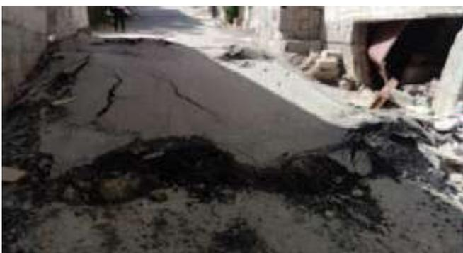
Constructions situées sur la surface de cisaillement (limites du glissement)
